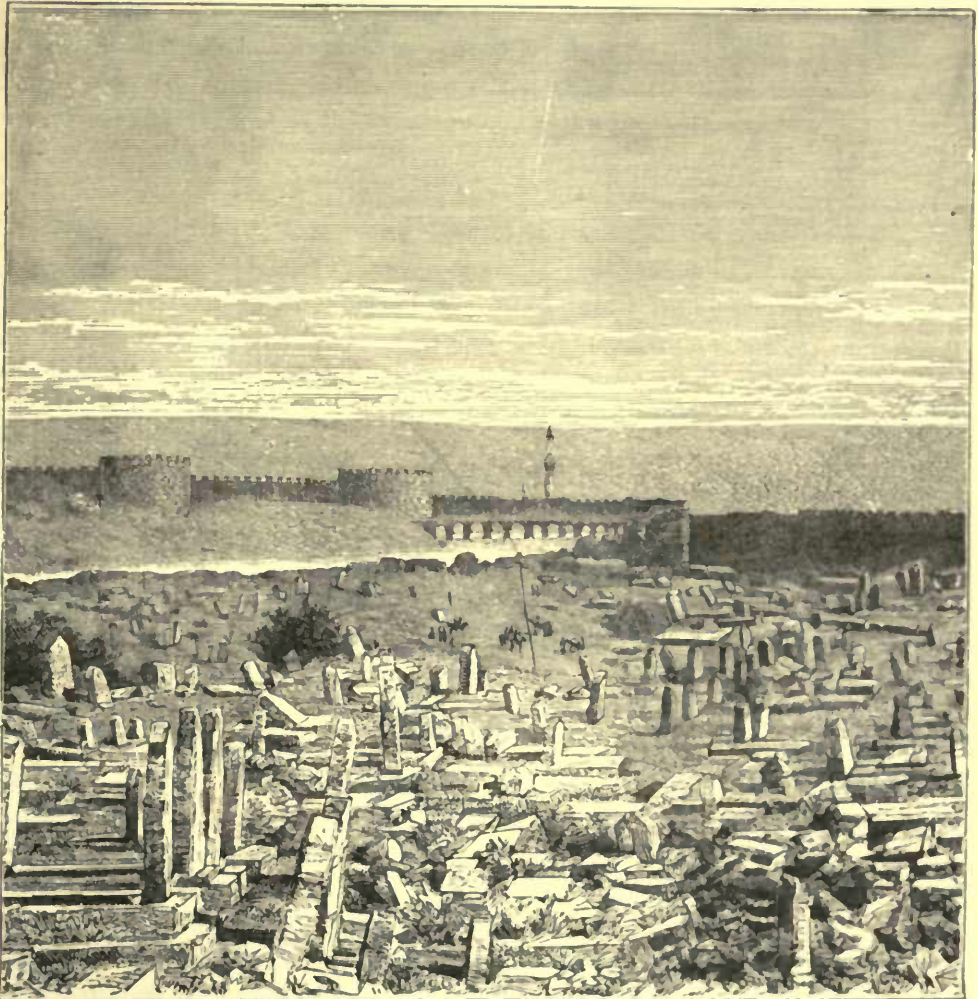
Fig. 82.—DIARBEKIR—BRIDGE OVER THE TIGRIS.
